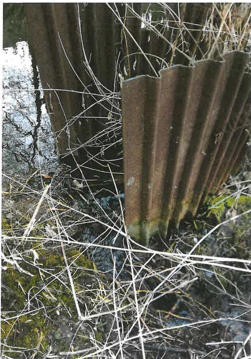
Obr. 2: Provizorní zabezpečení Union pažnicemi
